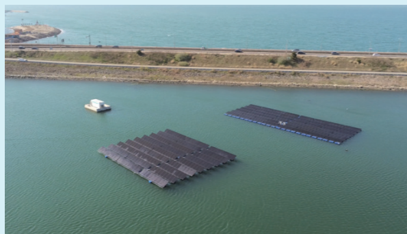
[그림 15. 200kW급 시화호 내수면 해상태양광 실증플랜트]
