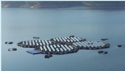
[그림 14. 100kW급 합천댐 추적식 수상태양광 실증플랜트]
