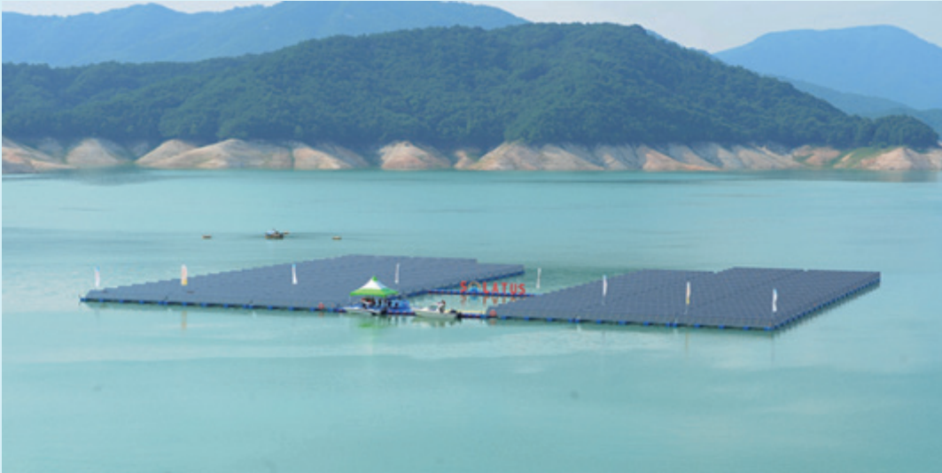
[그림 13. 세계최초 상용화 합천댐 500kW급 수상태양광 발전소]
