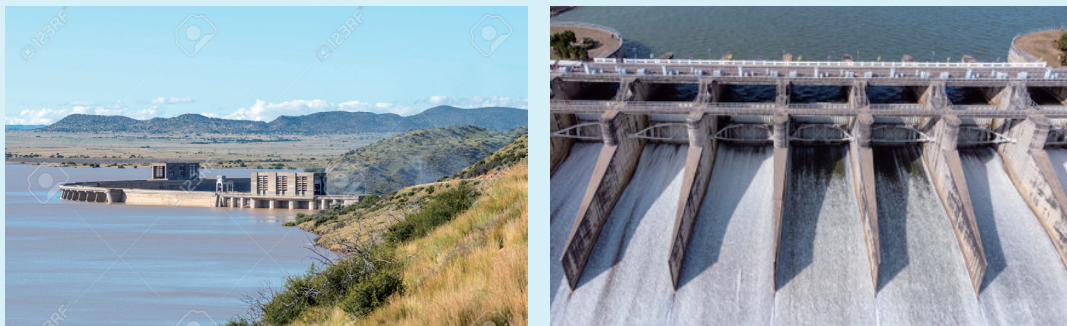
[그림 2. 남아프리카공화국 가리엵(Geriep) 댐 전경]
