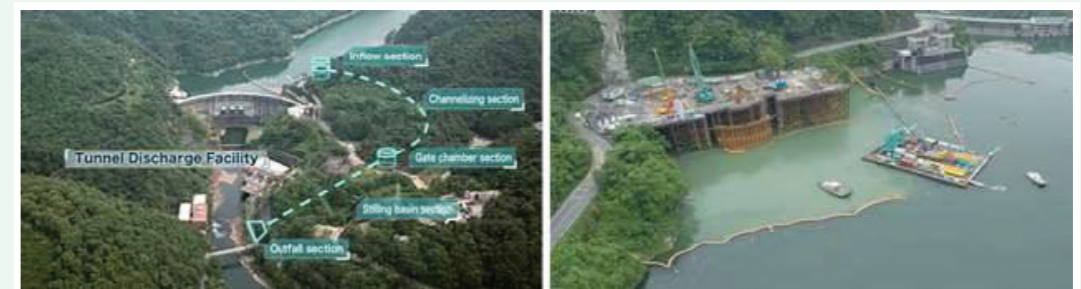
[그림 13] Amagase 댐 개선 전 후
