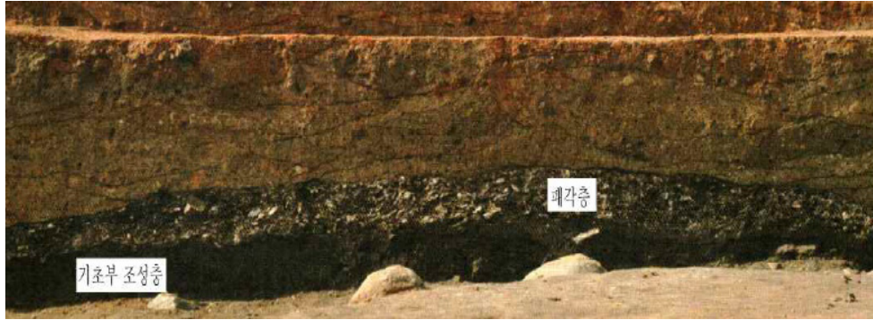
그림 12. 울산 약사동제방 기초부조성층과 기초성토층 내 패각층
