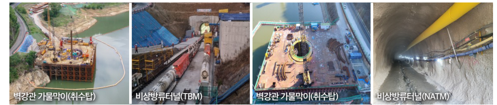
운문댐 공사추진 현황 영천댐 공사추진 현황
