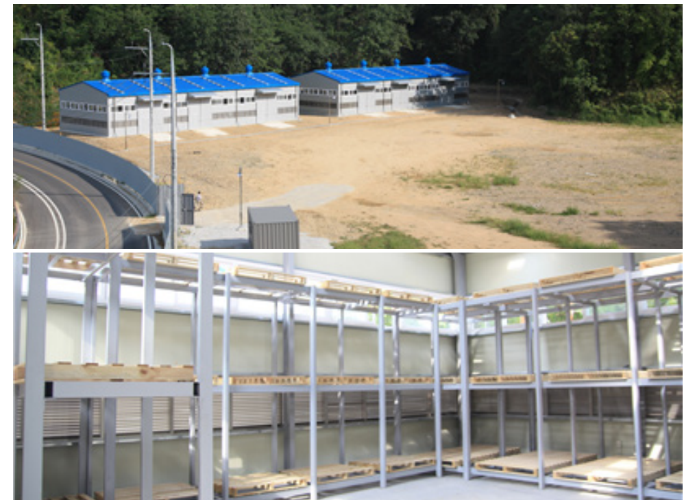
그림 11. 문화재 보관창고(32m×10m×7m×3동, 자연채광·통풍·침수방지 가능, 화재예방·도난방지 시설)
