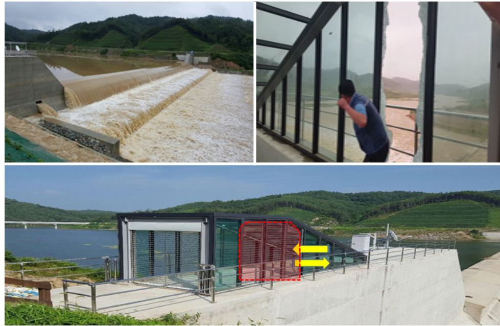
그림 17. 유사조절지 월류로 인한 구조물 진동발생 주장(유리창 일부 제거 후 공기흐름 원할, '16. 7.)
