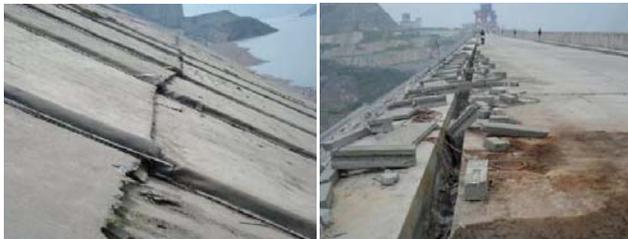
Fig. 4. 2008 중국 Wenchuan 지진시 Zipingpu CFRD에서의 (a) 콘크리트 차수벽 조인트 파단 및 이동, (b) 댐마루 펜스 지지대 손상 (Zhang et al. 2012)
