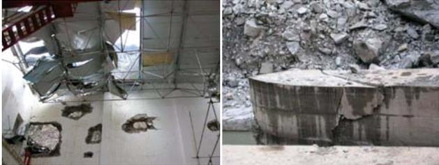
Fig. 8. 2008 중국 Wenchuan 지진으로 인한 Shapei 발전소 압괴 붕락 피해 및 압괴 붕락으로 인한 Minjiang 강의 Futan 위에 피어의 전단 손상 (ICOLD 2010)
