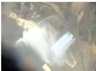
Fig. 5. 2008 중국 Wenchuan 지진시 Shapai RCC 댐에서의 Penstock 파괴와 발전소 범람 (Zhang et al. 2012)
