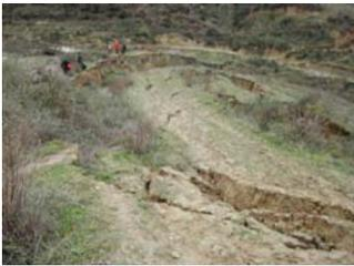
Fig. 13. 2009 Albania 지진으로 인한 Sharredushk 댐 사면 슬라이딩 (Hinks et al. 2012)
