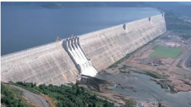
Fig.8 CFRD기술을 이용하여 시공된 Vajiralongkorn 댐 (www.gerd.eng.ku.ac.th, 1986)
