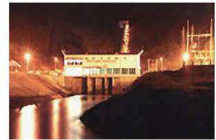
1: Tri_An HPP (Embankment, H40m, W400mil.m 3 , P450MW)
