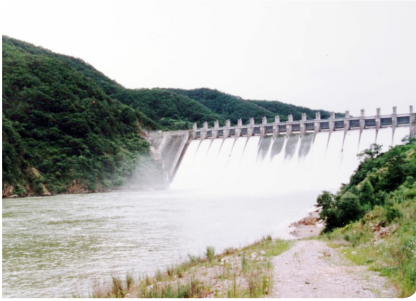
화천댐 방류 전경
