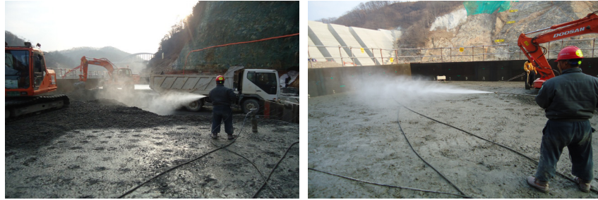
[그림 14] 시공 중 분무기 모습
