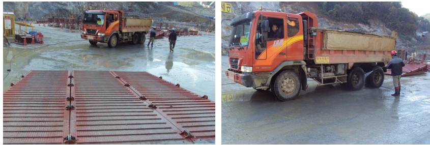
[그림 6] 진입용 등판차로 및 이동식 세륜 설비
