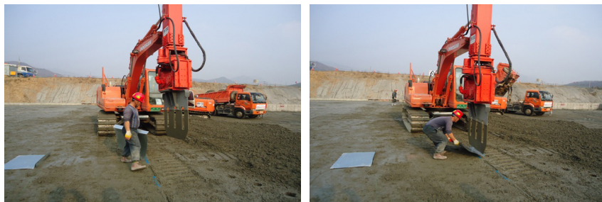
[그림12] 줄눈강판 설치 모습
