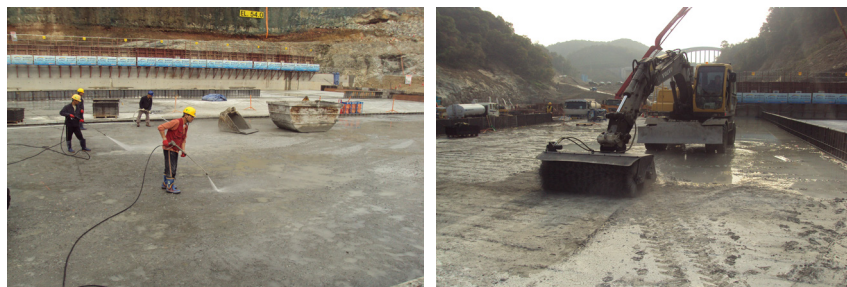
[그림15] Green Cut작업 모습
