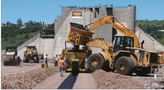
〈그림 6〉 ACRD에서 아스팔트 콘크리트의 포설 작업 (Veidekke)
