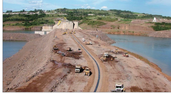
〈그림 7〉 Foz-Do Chapeco 댐의 아스팔트 콘크리트 코어 시공 전경 (Veidekke)
