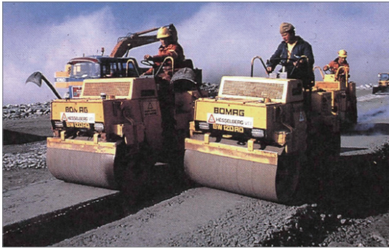
〈그림 8〉 아스팔트 콘크리트 코어재와 필터재의 동시 다짐작업 (Höeg 1993)
