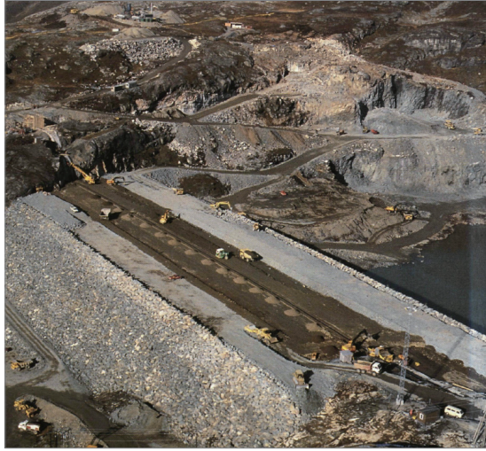
〈그림 3〉 Berdalsvatn 댐 시공 전경 (높이 65m, 길이 465m, 체적 1백만m 3 ) (Höeg 1993)
