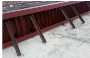
레일폼 지지대 설치 사진
