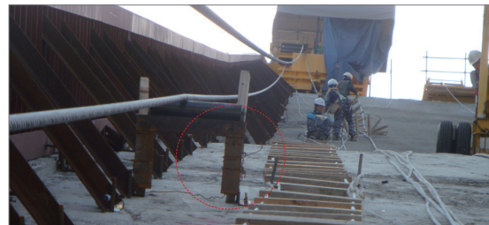
<그림 32> 당초 와이어로프 끌림(좌) 및 개선 와이어로프 지지대 설치(우)
