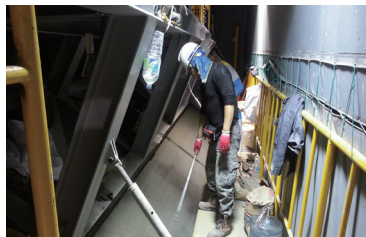
〈그림 16〉 피막양생 전경(좌) 및 살수양생 모식도(우)
