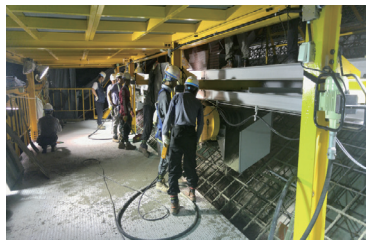
〈그림 15〉 콘크리트 다짐 전경(좌) 및 타설층 형성 모식도(우)
