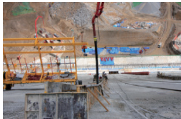
몰탈패드 타설 전경
