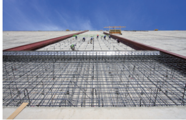
〈그림 12〉 철근 및 데크플레이트(수평이음) 설치 전경(좌) 및 데크플레이트 설치 모식도(우)
