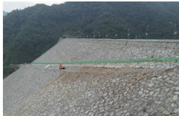
기존 댐 하류사면 전경 및 도로 철거 착수
