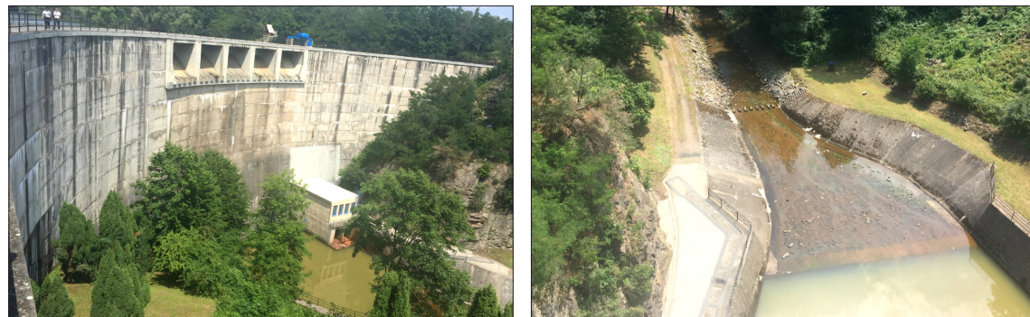
Vrchlice Dam의 전경(左), 방류부(右) 사진
