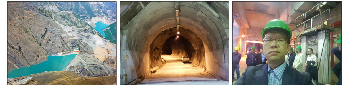
〈그림 6-1〉 Siah Bisheh 댐(전경) 〈그림 6-2〉 Siah Bisheh 댐(발전터널) 〈그림 6-3〉 Siah Bisheh 댐(발전시설)
