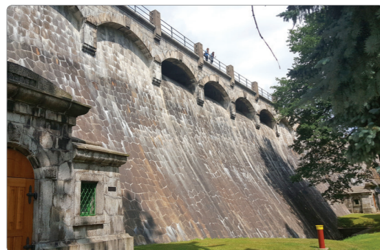
ICOLD - 기술투어 (Mseno Dam) (7.6)
