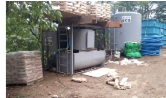
벤토나이트 혼합 믹서기 설치
