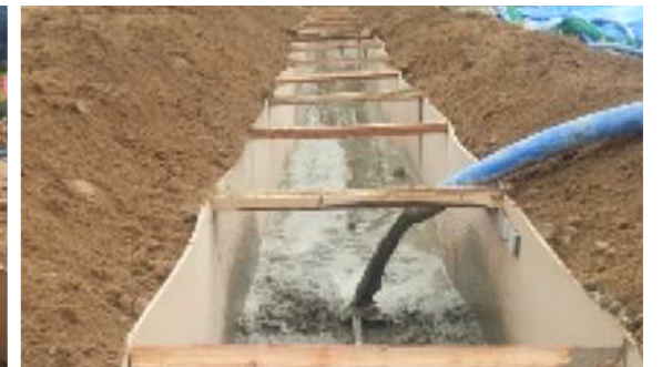
캐핑 타설 전경
