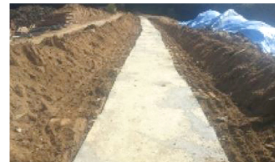
차수벽 최종설치 전경
