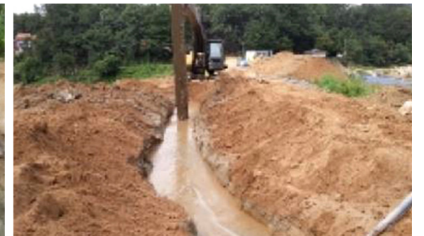
굴착 및 주입 전경 (연속작업)
