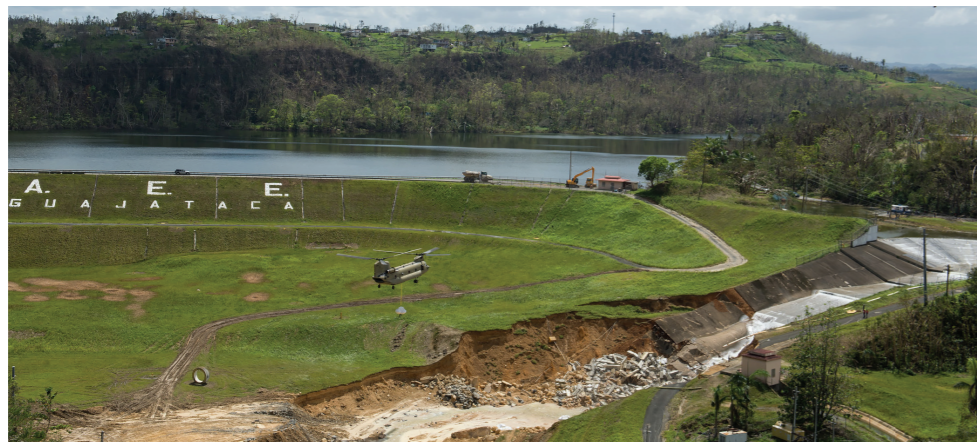
콘크리트 블록 반입 (17. 10. 9)
