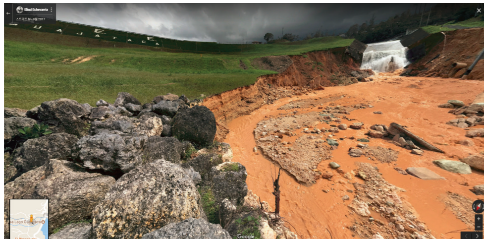
피해발생 후 여수로 (Google Maps 스트리트 뷰) <그림 3> 과타타카 댐 여수로 및 감세공의 피해 전·후 사진 비교
