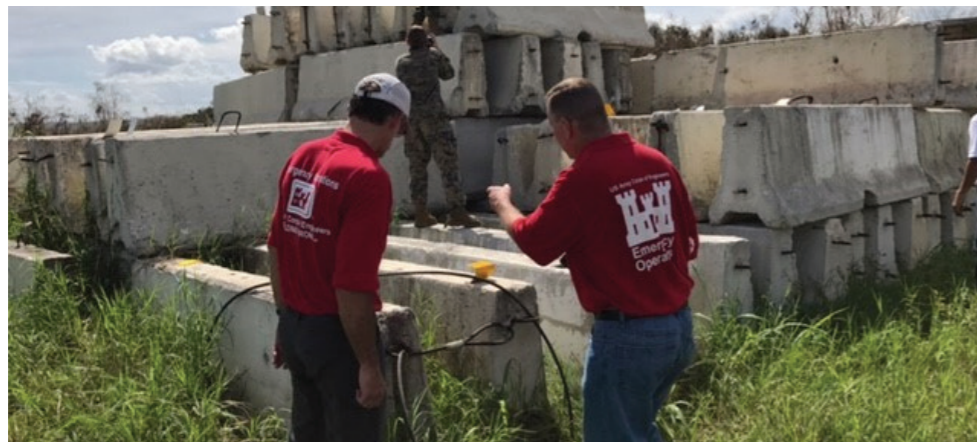
과타타카 댐 여수로 복구용 콘크리트 블록(17. 10. 9)
