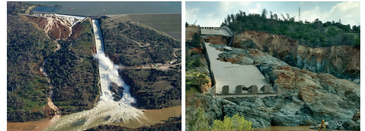
〈그림 1〉 Oroville Dam 사고사례
