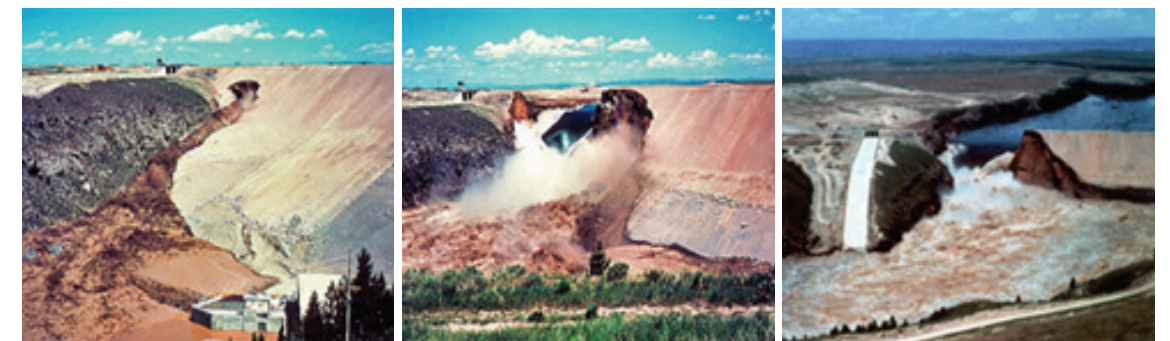
〈그림 2〉 Teton Dam 붕괴사례 (담체손상에 따른 붕괴진행)
