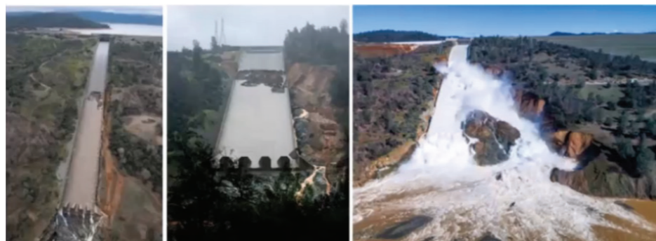
미국 캘리포니아 Oroville dam 피해현황
