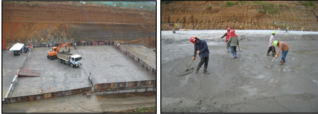
그림 17. RCD Mortar 포설
