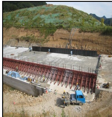
(b)안전난간대설치
