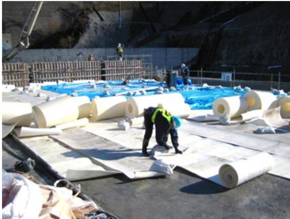
단열 매트 설치 t=10\sim30\text{mm}
