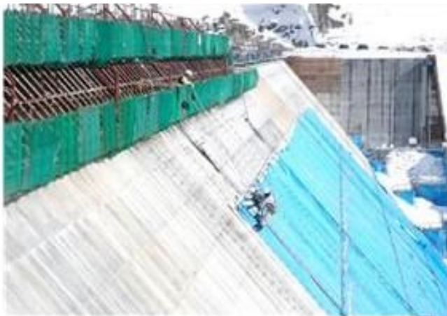
하류면 시공 상황 단열 매트 t=10\text{mm} + 시트
